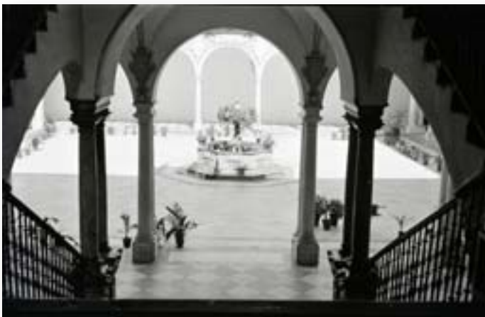
Vista del patio del Colegio de La Merced desde la escalera principal.
