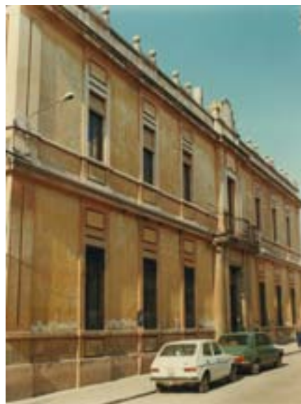
Proyecto de reparación del Ayuntamiento de Peñarroya, 1981.
