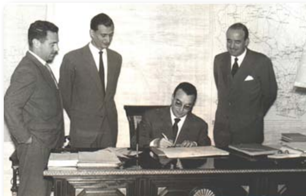
Firma del contrato para la construcción del edificio de la Caja Provincial de Ahorro. 20 mayo 1959.
