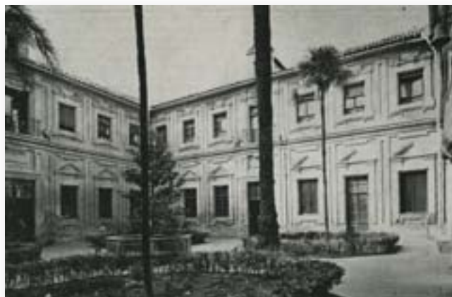
Hospital de Agudos, puerta de acceso y patio interior.
