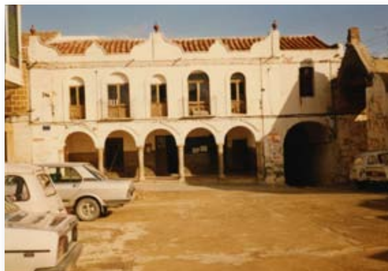
Proyecto de reparación de cubiertas del mercado de Santa Eufemia 1982.
