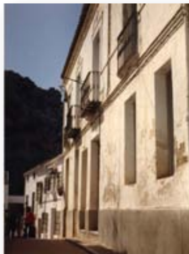
Proyecto de reparación y reforma del Ayuntamiento de Zuheros, 1982.
