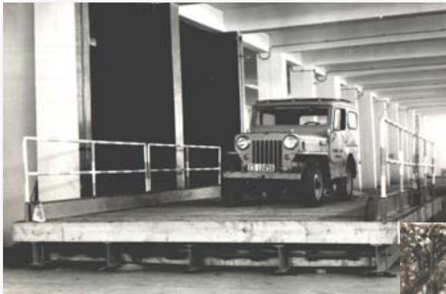
Puente portatil, construido en el Parque Central de la Diputación, en previsión de necesidades urgentes. En la foto prestando servicio entre Rute e Iznajar, en el camino de la Aldea de la Hoz.
