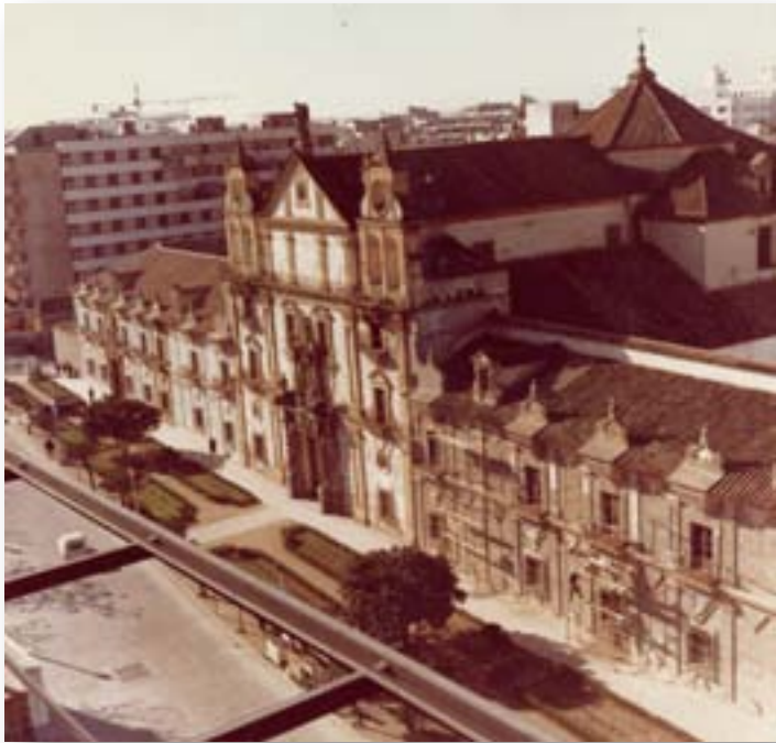
Obras en la fachada.
