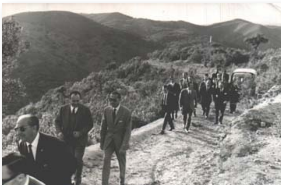
Las autoridades provinciales visitan los nuevos caminos en construcción que facilitarían la promoción turística de la Serranía de Córdoba.
