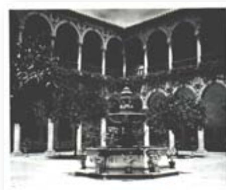
Fachada y patio principal de La Residencia Infantil el Carmen.
