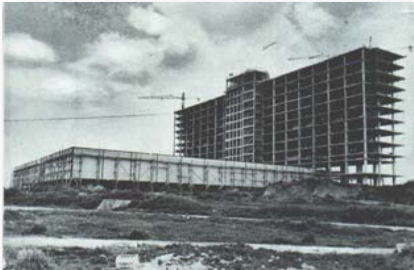
El nuevo hospital provincial en construcción.
