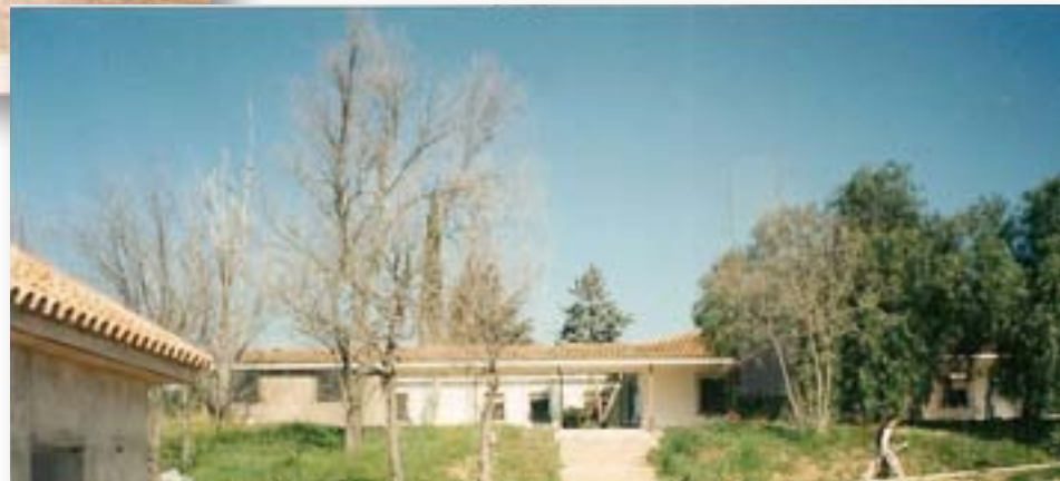
Vistas del centro de disminuidos psíquicos en Alcolea.
