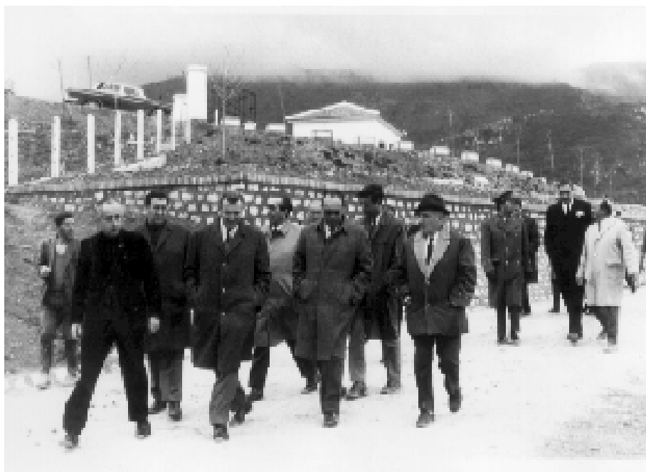
Fotografía 40: Visita a las obras de abastecimiento de agua a Doña Mencía, 7 de febrero de 1968
