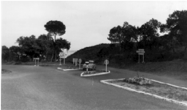
Fotografía 33: Carretera de Trasierra en el cruce con la de las Ermitas.
