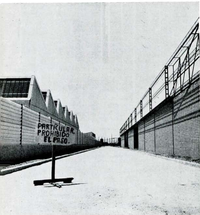
Las fotografías que ilustran este trabajo corresponden a distintas obras del Polígono Industrial de "La Torrecilla", lugar cercano a Córdoba, en el que va a ser instalado un interesante complejo.
