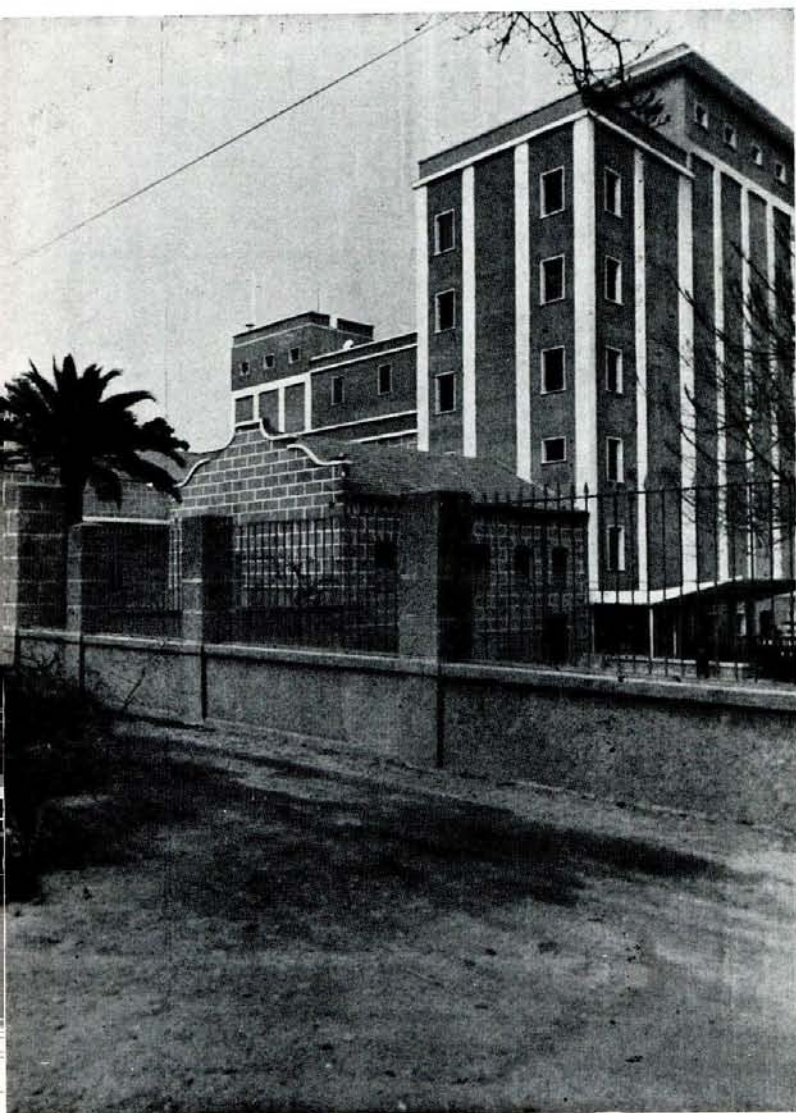
Aspecto de la fábrica de harinas de La Rambla, en la que puede apreciarse el silo de trigo, cuerpo de fábrica y silo para harinas.
