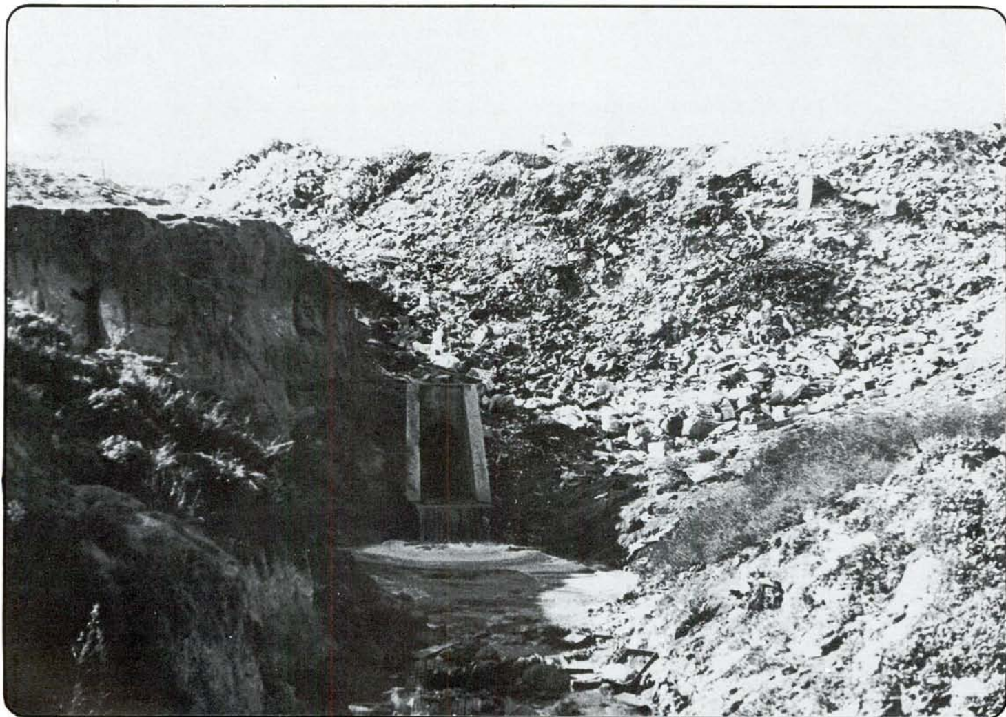
Vertedero sobre la salida del colector. Estos problemas graves contra la salud, son los que ahora va a combatir la Diputación.
