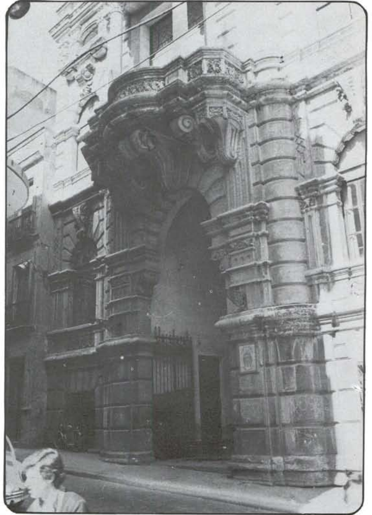
Fachada principal del edificio que ha ofrecido la Diputación para una Escuela Politécnica de Estudios Empresariales e Informática, ubicado en la calle Alfonso XIII.
