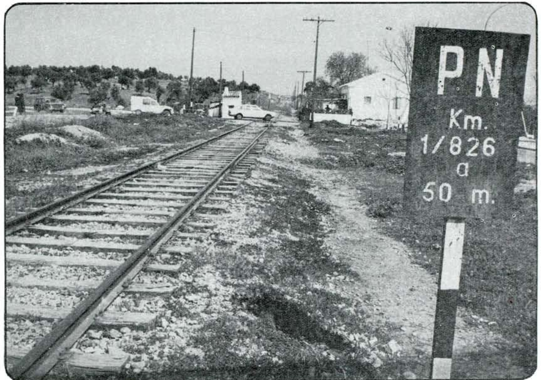
La supresión de pasos a nivel ferroviarios un tema abordado por la Diputación.
