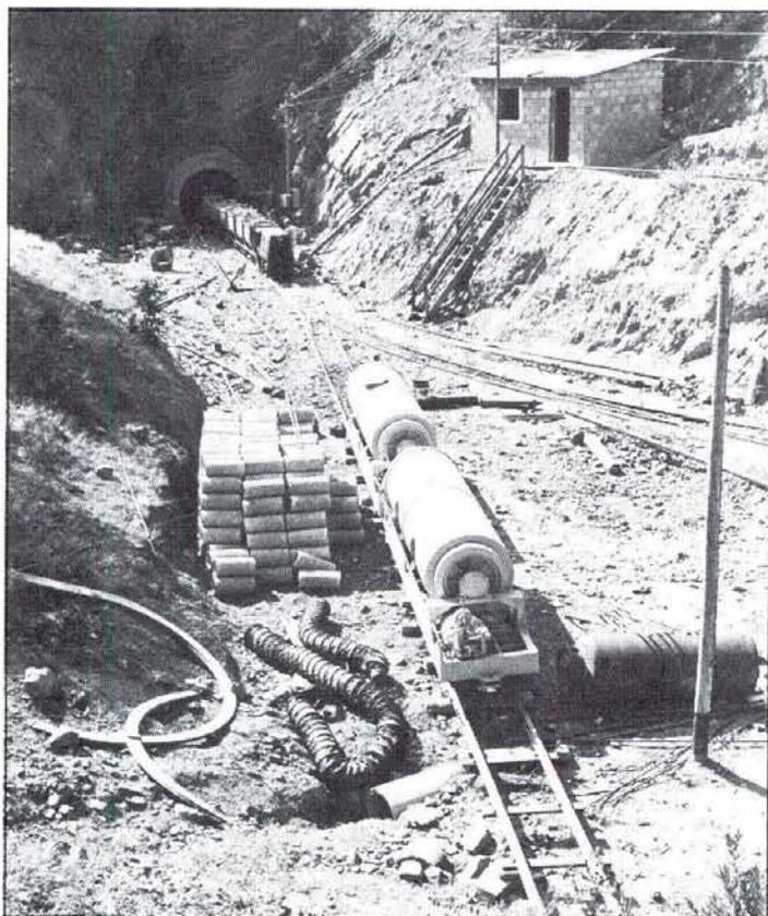
*Construcción del segundo acueducto del embalse del Guadalmellato a la Central Depuradora de Villa Azul. El tramo es de 3.400 kilómetros de longitud y la sección tiene 2,25 de diámetro.*
