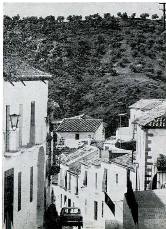
Montoro: Calle típica, balcón sobre el olivar
