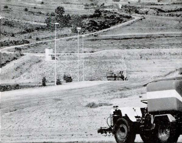
Aspecto general de un vertedero controlado
