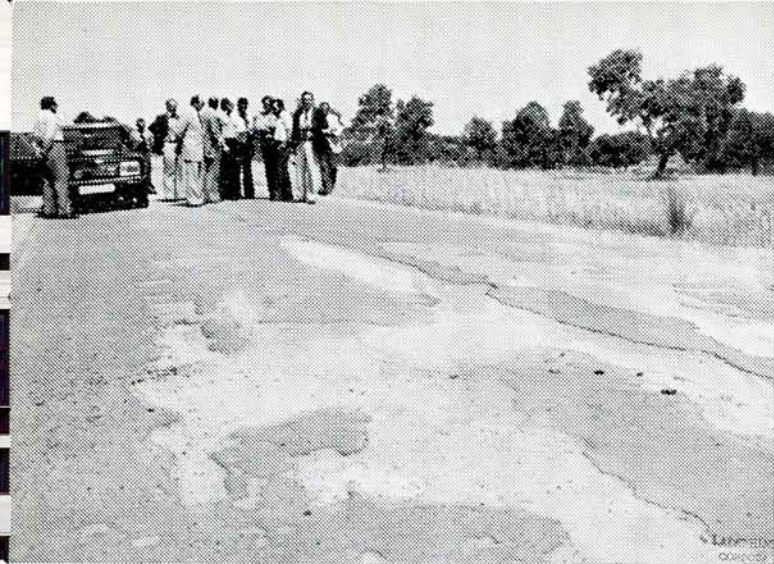
El Presidente observando el mal estado de una de las carreteras del Norte de la provincia, durante uno de sus viajes al Valle de los Pedroches
