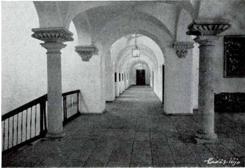
Esta es una de las amplias y luminosas galerías superiores del Palacio del Cardenal Salazar, idealmente restaurado para Colegio Universitario de Córdoba
