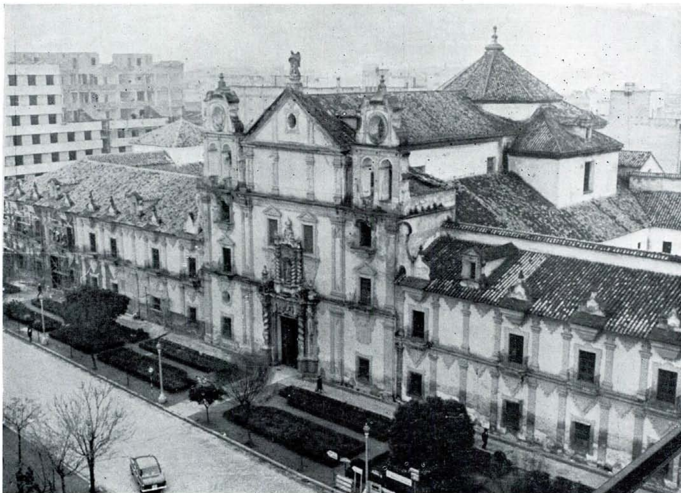
Perspectiva del Convento de la Merced, cuya fachada, sometida a restauración, dió lugar a esta encuesta
