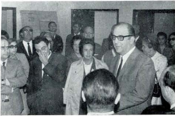
Don Rafael de La Hoz, uno de los arquitectos autores de los proyectos, explica las características del Hospital Psiquiátrico a un grupo de visitantes
