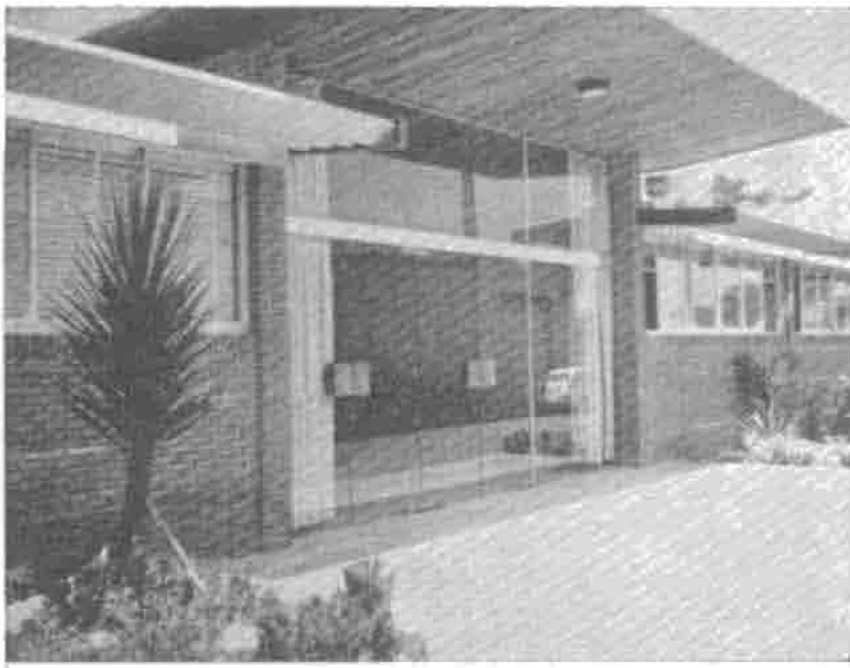
Vista parcial de la fachada del Colegio "Ponce de León".
