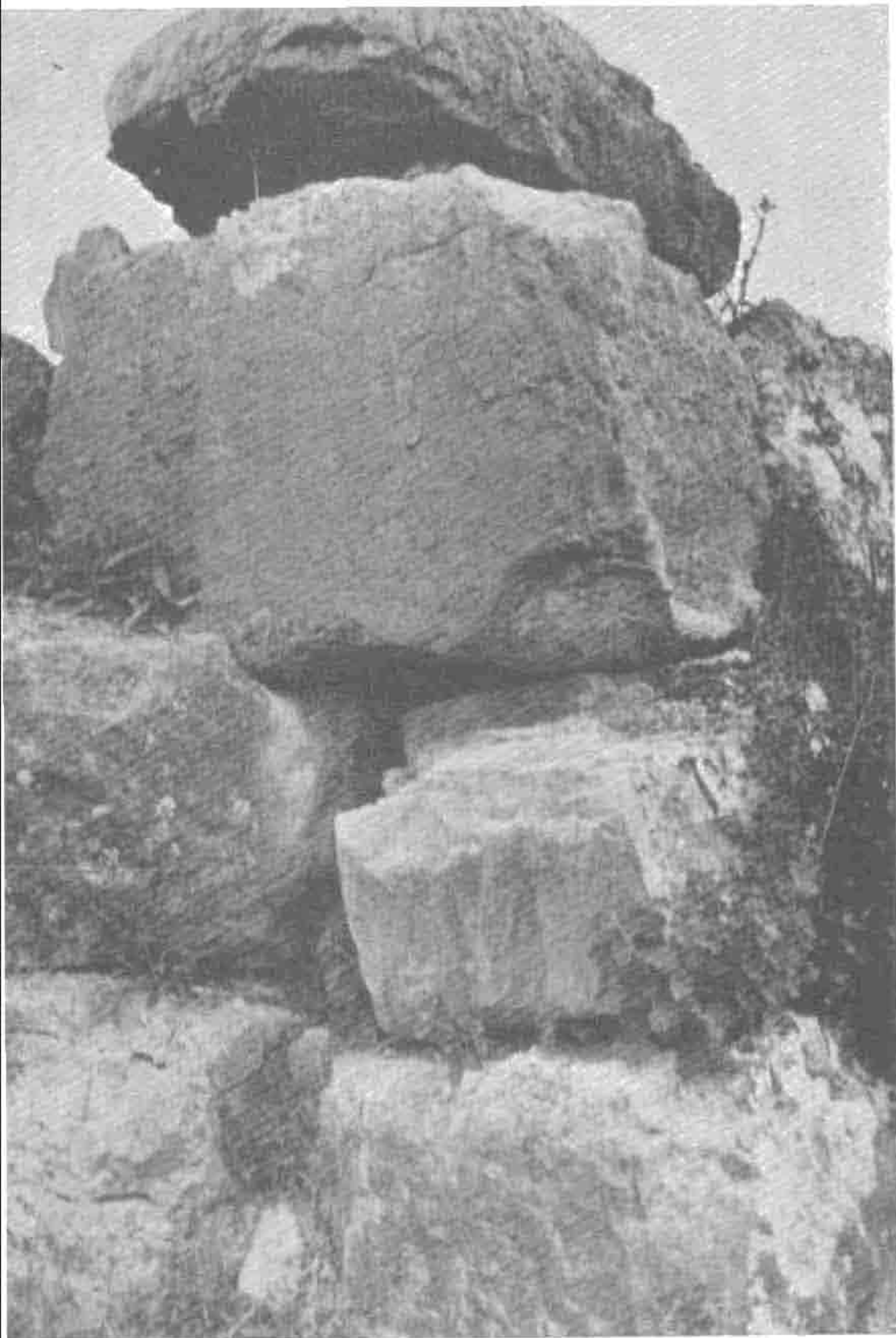
Muros con sillares de hasta seis toneladas en los recintos ibéricos descubiertos.
