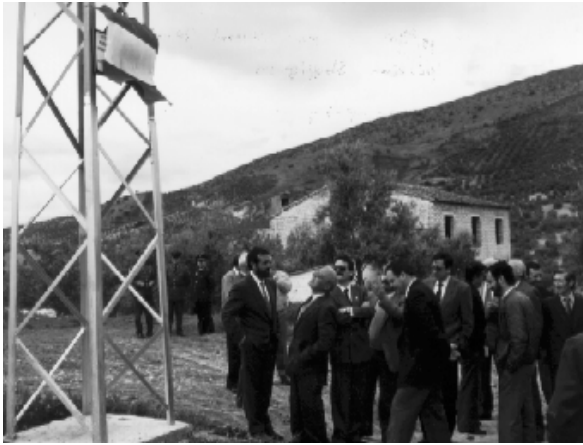
SE FUE COMPLETANDO LA ELECTRIFICACIÓN Y EL ALUMBRADO EN TODOS LOS PUEBLOS DE LA PROVINCIA
