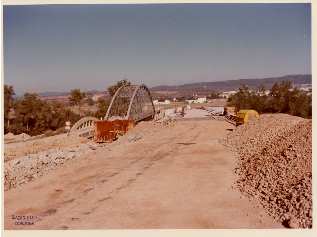
Fotografía 75: obras en el Puente de Villafranca (Foto Archivo Diego Romero)
