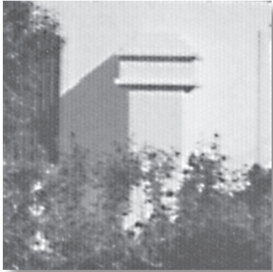
Detalle de los contrafuertes, testigos del antiguo edificio reformado y ampliado en 1967 por el arquitecto provincial Rafael de la Hoz Arderius.
