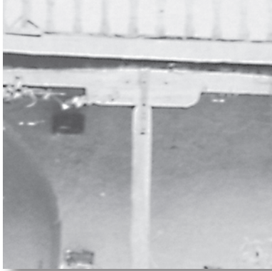
Detalle de la zapata o madero corto que realiza la función de calzo de la estructura superior..
