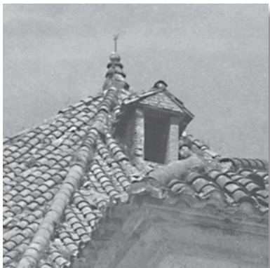
Detalle de la ventana ubicada en la cúpula cuya función de linterna ilumina el interior del recinto.
