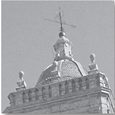
Detalle de la cúpula bulbosa recubierta por azulejería, rematada con una pequeña linterna.
