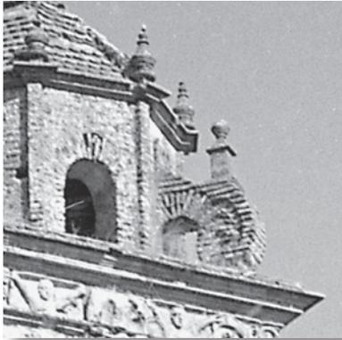
*Detalle del arbotante con forma de voluta del cuerpo octogonal, que realizado en ladrillo, configura una bella imagen al coronamiento de la torre junto con su cubierta en forma de chapitel..*
