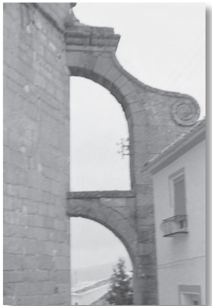
Detalle de los arbotantes del presbiterio de la Parroquia de Santiago, con dos medios arcos superpuestos, levantados a principios del siglo XVIII por Francisco Delgado, maestro mayor de la catedral de Granada.
