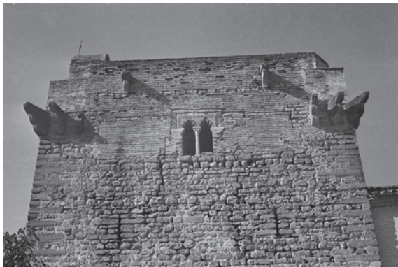
Detalle de la parte superior de ladrillo, en la que se añadió una ventana geminada con arcos lobulados tipo mudéjar.
