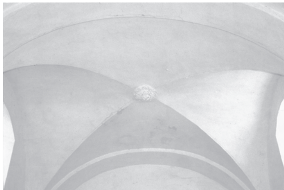
Detalle de las bóvedas de arista que cubren cada uno de los tramos en los que se dividen la nave principal y lateral.
