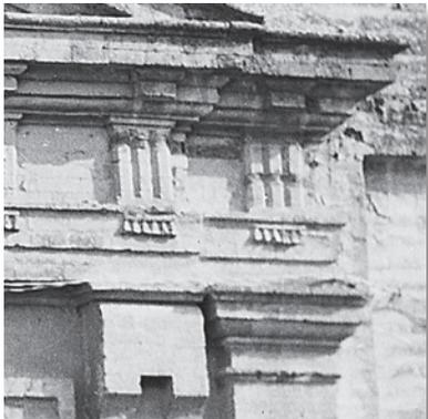
*Detalle del friso de la portada de la Casa del conde del Colchado que traduce el nervio de una piedra geoméricamente tallada. En él se percibe la nitidez de las metopas y triglifos que la decoran, y las golas que decoran la base del triglifo. Sobre el alero el arranque del frontón. Y en la parte inferior los capiteles que rematan las pilastras.*
