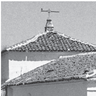
Detalle de la cabecera de la ermita en la que sobresale el cimborrio, de tambor cuadrado, que cierra el presbiterio.
