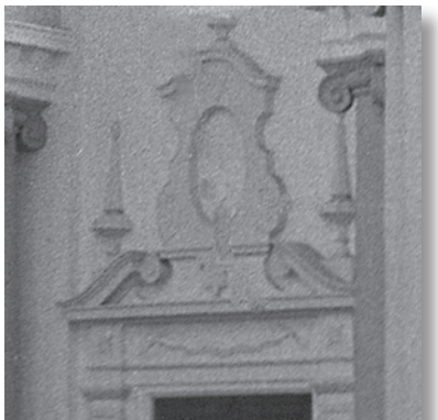
Detalle de la decoración de las puertas del ábside con medallones de perfil barroco, volutas y pináculos.
