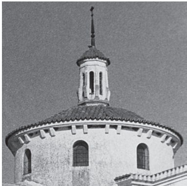
Detalle del cimborio, de tambor circular, y de la linterna que corona la cúpula, que cierran el crucero y cuyas ventanas aportan gran luz al interior de la iglesia.
