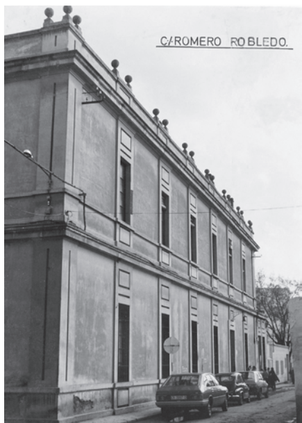
Vista de la fachada posterior del edificio, que da a la calle Romero Robledo.
