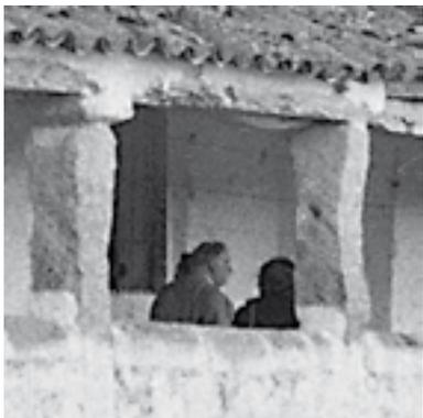
*Detalle del pórtico adintelado, a base de toscos pilares de piedra y vigas transversales de madera.*
