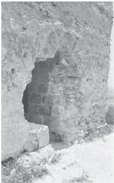
Detalle de una puerta de acceso a la torre que se conserva en la actualidad.
