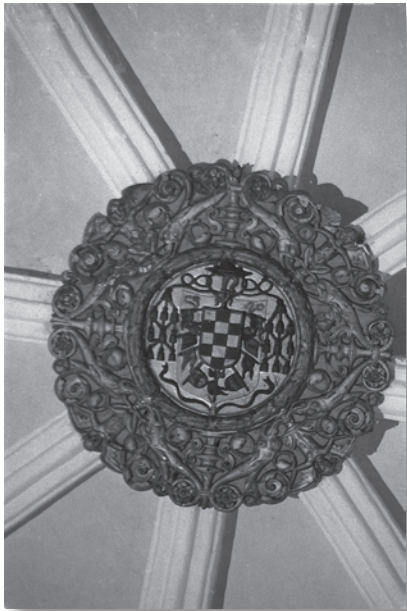
Detalle de la clave de la bóveda, en la que hay un escudo episcopal billetado en faja y con banderas.
