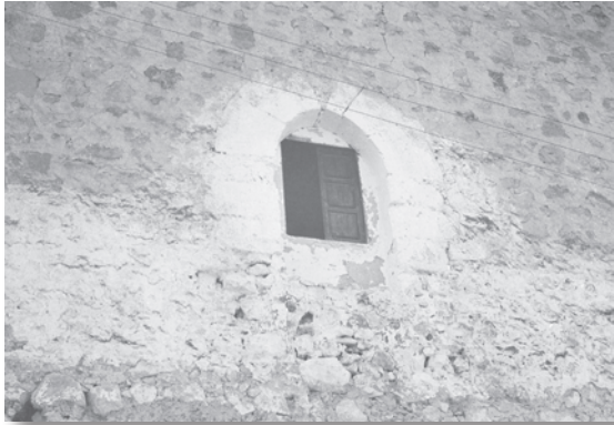
Detalle de la ventana de la torre.
