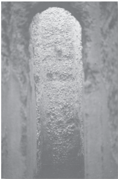
Detalle de la bóveda de medio cañón de una de las cubiertas, y pared de cemento romano (Opus Caementicium, Opus signium).
