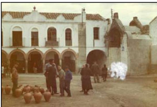
Este tipo de arco es un recurso constructivo muy utilizado en la arquitectura concejil de España, ya que sin tener que interrumpir la comunicación entre diferentes vías, se expande el edificio en su parte superior abarcando una mayor superficie de aprovechamiento burocrático.
